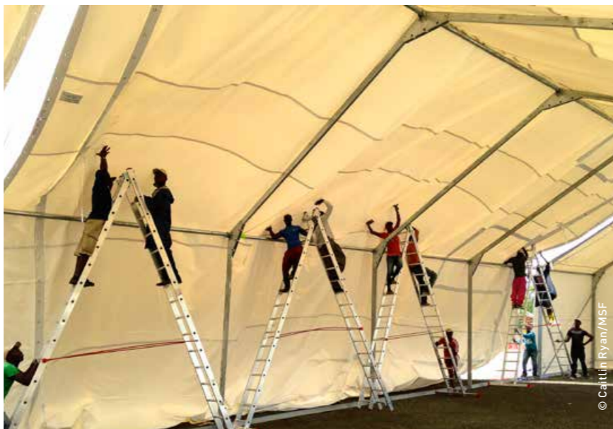
在利比里亚首都蒙罗维亚，施工队正在建设中的ELWA 3号埃博拉治疗中心，这是世界上最大的埃博拉治疗中心，拥有250张床位。
